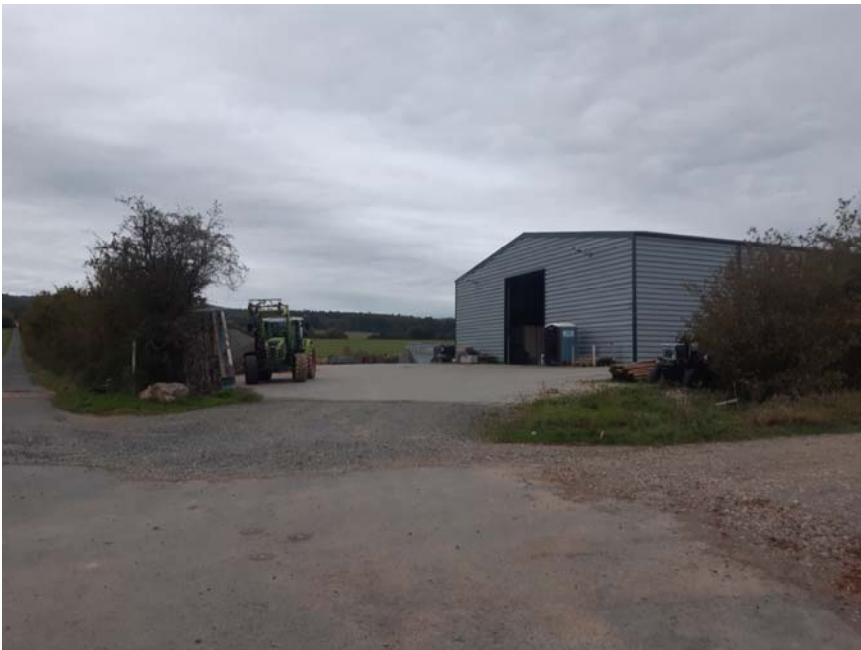
Zufahrt von Schulstraße – best. Lagerhalle
