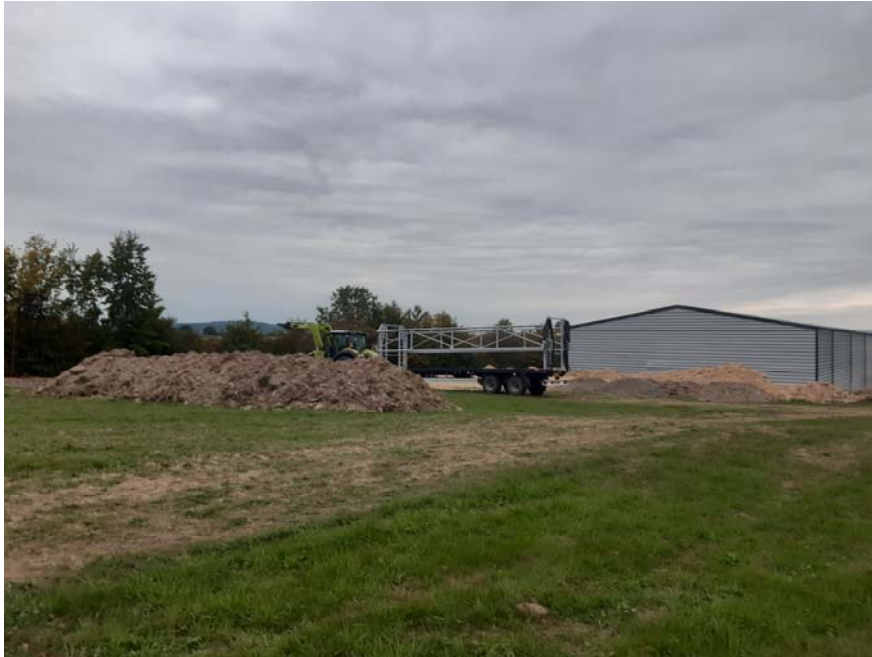
Blick Richtung Süd-West, best. Lagerhalle, -fläche
