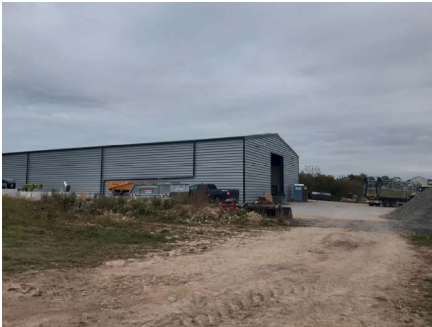
Blick Richtung Süd, best. Lagerhalle, -fläche
