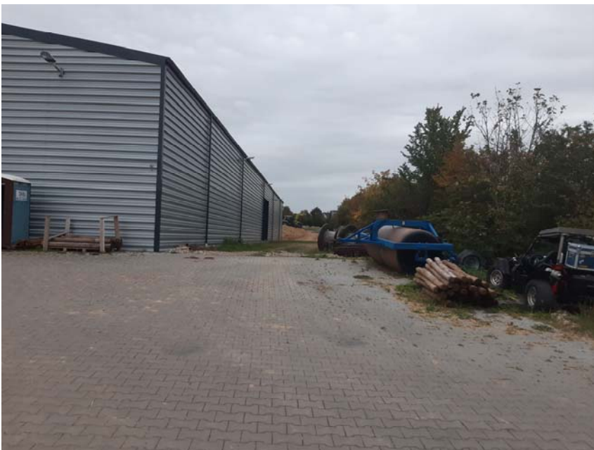
Blick entlang der best. Lagerhalle Richtung Ost
