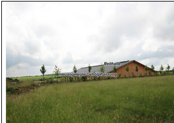
Foto 9: fertiggestellte Reithalle mit randlicher Bepflanzung; Aufnahme: 03.06.2016
