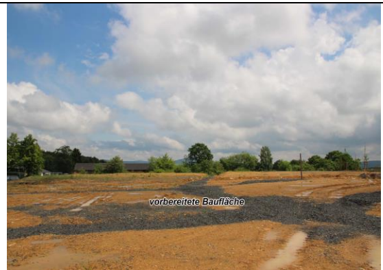
Foto 10: Baufläche zwischen Reithalle u. Römerstraße; Aufnahme: 03.06.2016
