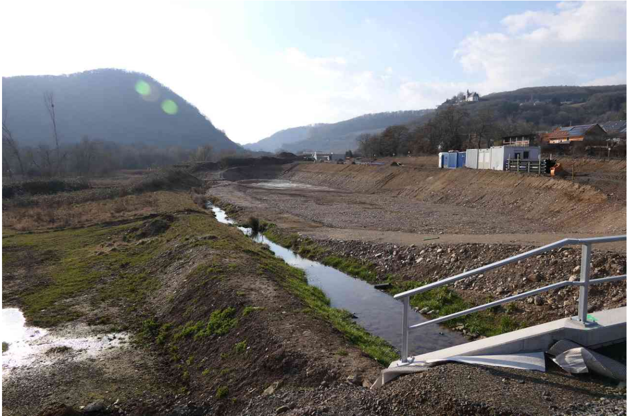
Abb. 3: Regenrückhaltebecken westlich der neuen Erschließungsstraße, verlegter Bachlauf
