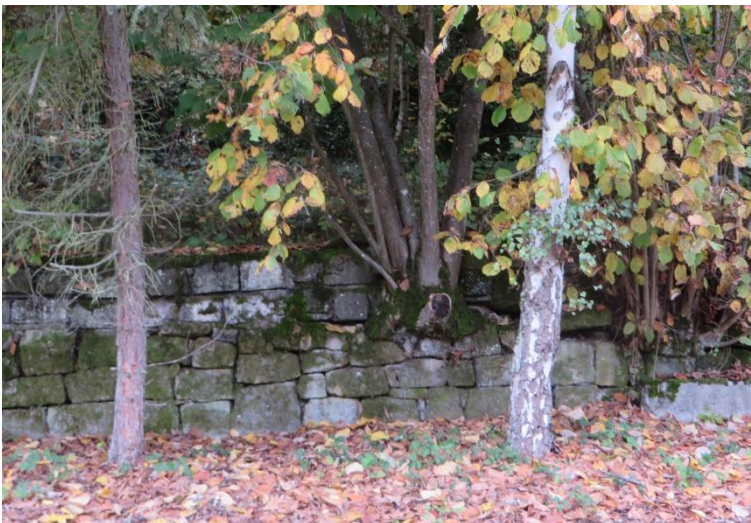
Abbildung 8: Natursteinmauer unverfugt
