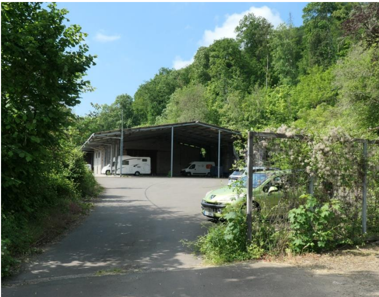
Abbildung 10: Lagerhalle mit versiegelter Vorfläche (HT1)
