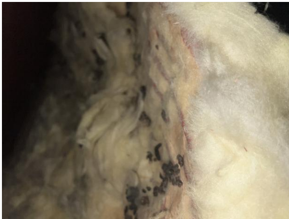
Abb. 8 a, b: Gefundener Bilchkot im Dachstuhl (links), teils zerrissene und zerfressene Dämmwolle auf dem Dachstuhl (rechts).
