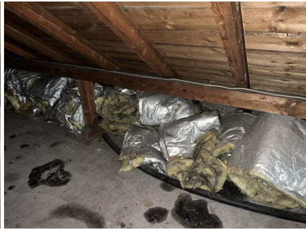
Abb. 7 a, b: Gefundener Kleinsäugerkot im Dachstuhl (links), teils zerrissene und zerfressene Dämmwolle auf dem Dachstuhl (rechts).
