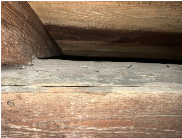
Abb. 7 a, b: Gefundener Kleinsäugerkot im Dachstuhl (links), teils zerrissene und zerfressene Dämmwolle auf dem Dachstuhl (rechts).
