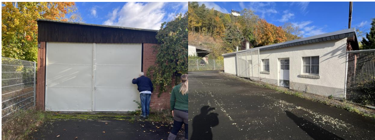
Abb. 10: Blick auf die Garage und das kleine Nebengebäude, die aufgrund fehlender Zugangsmöglichkeit nur von außen kontrolliert werden konnten.
