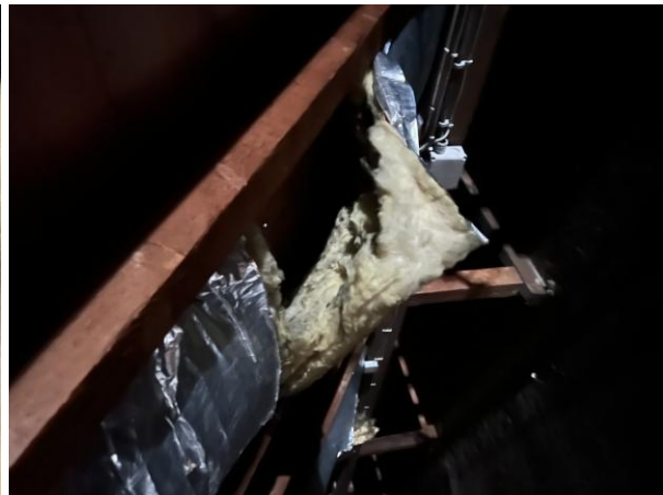
Abb. 8 a, b: Gefundener Bilchkot im Dachstuhl (links), teils zerrissene und zerfressene Dämmwolle auf dem Dachstuhl (rechts).
