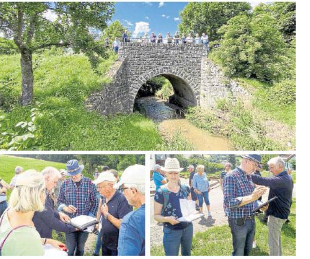
An ruhigen Sonntagsmorgen sieht der Bärenbach sehr idyllisch aus. Bei Starkregen kann sich das sehr schnell ändern. Daher ist der Hochwasserschutz in Bärenbach ein wichtiges Thema. An der vierstündigen Ortsbegehung mit den Fachleuten des Mainzer Ingenieurbüros Icon nahmen mehr als zwei Dutzend Bürger teil. Die Hochwasserexperten nahmen sich viel Zeit für Gespräche mit den Anwohnern, und ließen sich kritische Stellen zeigen.
