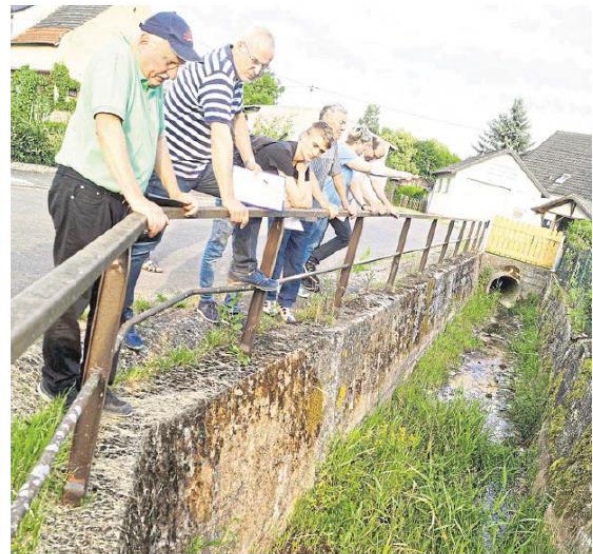
Das Starkregen- und Hochwasserschutzkonzept bewegt die Gemüter. In Limbach kamen drei Dutzend Bürger zur Bestandsanalyse ans Bürgerhaus und gingen durch den Ort und zum Ortsteil Weilschrötherhof.
